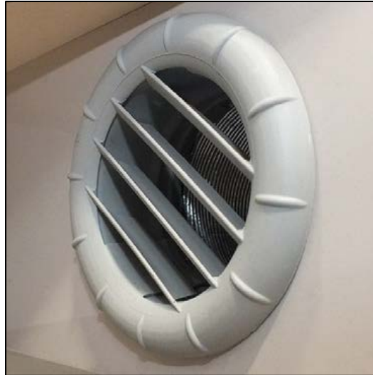
Austrittsöffnung (Ausströmer) Warmluft
