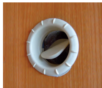
Lüftungsöffnung für warme Luft
