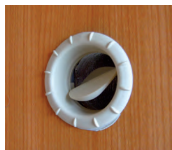
Ventilasjonsåpning for varm luft
