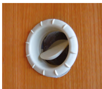
Lüftungsöffnung für warme Luft
