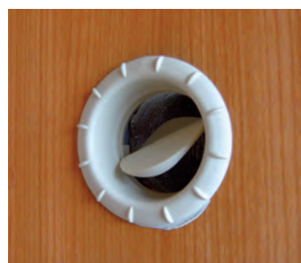
Ventilasjonsåpning for varm luft
