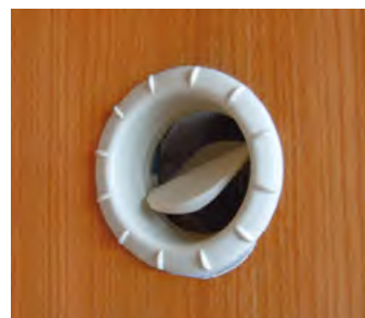
Lüftungsöffnung für warme Luft
