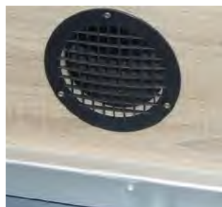
Ansaugöffnung für kalte Luft
