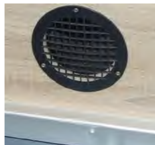
Ansaugöffnung für kalte Luft
