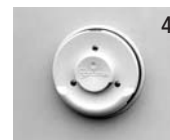
4 Abluftöffnung für Heizung
