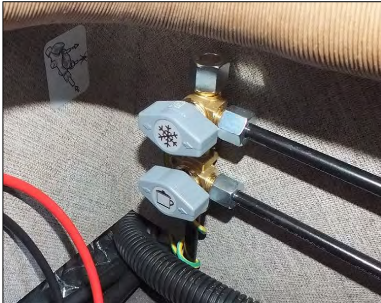
Gas-Absperrventile unter der Sitzbank (Abb. beispielhaft)
