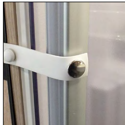
Sécurisation de la porte de douche par un bouton-pression (exemple)
