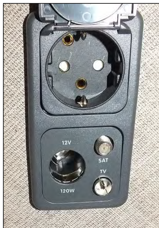
Prises électriques dans la zone de couchage (exemple)
