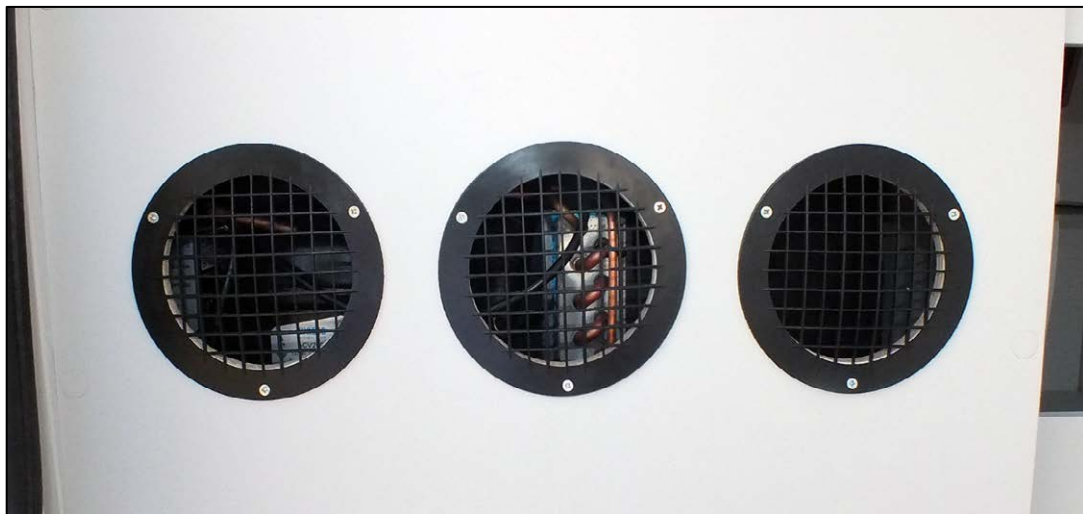
Rückseitige Zu- und Abluftöffnungen des Kühlschranks (Abb. beispielhaft)
