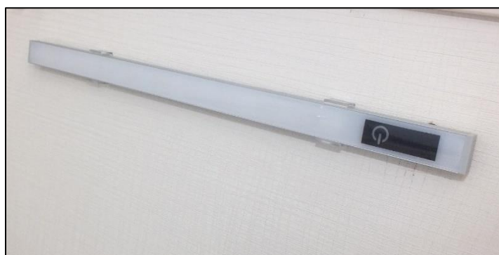
Barra de luz en el techo del baño/váter con tecla de sensor (imagen de ejemplo)
