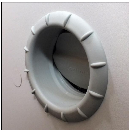
Orificio de salida de aire caliente
